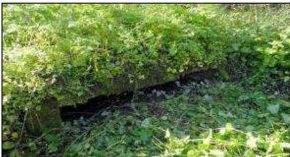
Le chargement de la péniche s'effectuait à l'aide d'un tapis roulant situé dans un tunnel. Les granulats stockés sur le sol, au-dessus du tunnel, et contrôlés par des trappes, descendaient par gravité sur le tapis roulant qui débouchait à l'air libre au niveau du quai. C'est cette trace qu'on peut encore distinguer même si l'ouverture a été comblée par mesure de prudence.
