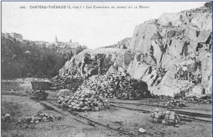
*On remarquera ici, au pied du front de taille, le wagonnet sur rails mobiles qu'on déplaçait en fonction des besoins. La position du clocher indique que le travail s'effectue sur le front de taille le plus ancien.*
